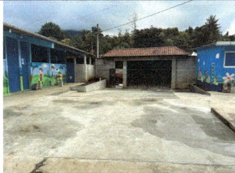
Foto1: reparación de corredor
