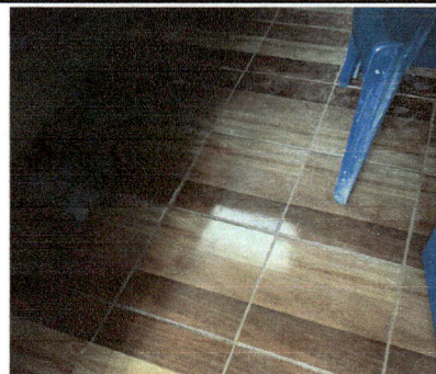
Foto 6: colocación de piso ceramico
