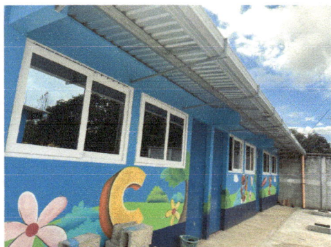
Foto 3: pintura de aulas
