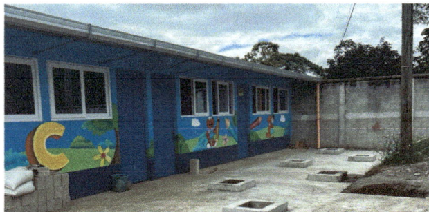
Foto 5: colocación de ventanas
